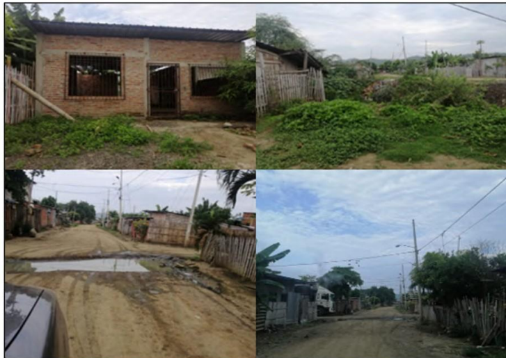
Figura 2. Estado actual del cañón urbano Elaborado por: los autores
