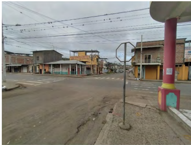
Figura 5. Ausencia de la señal de pare en la intersección de la calle Parrales y Guale con Escobedo
