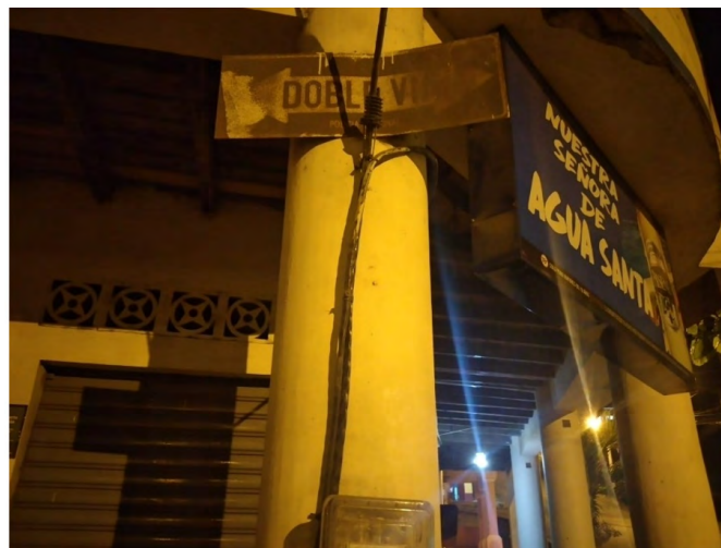
Figura 2. Falta de visibilidad de la señalética
